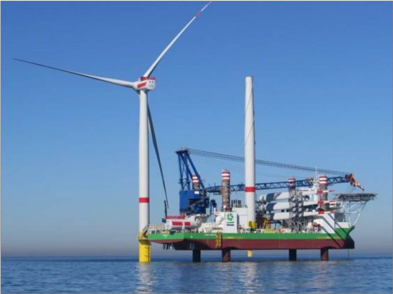
Bild 3-11. Installation av ett havsbaserat vindkraftverk med ett jack-up-fartyg (bild: COWI).
