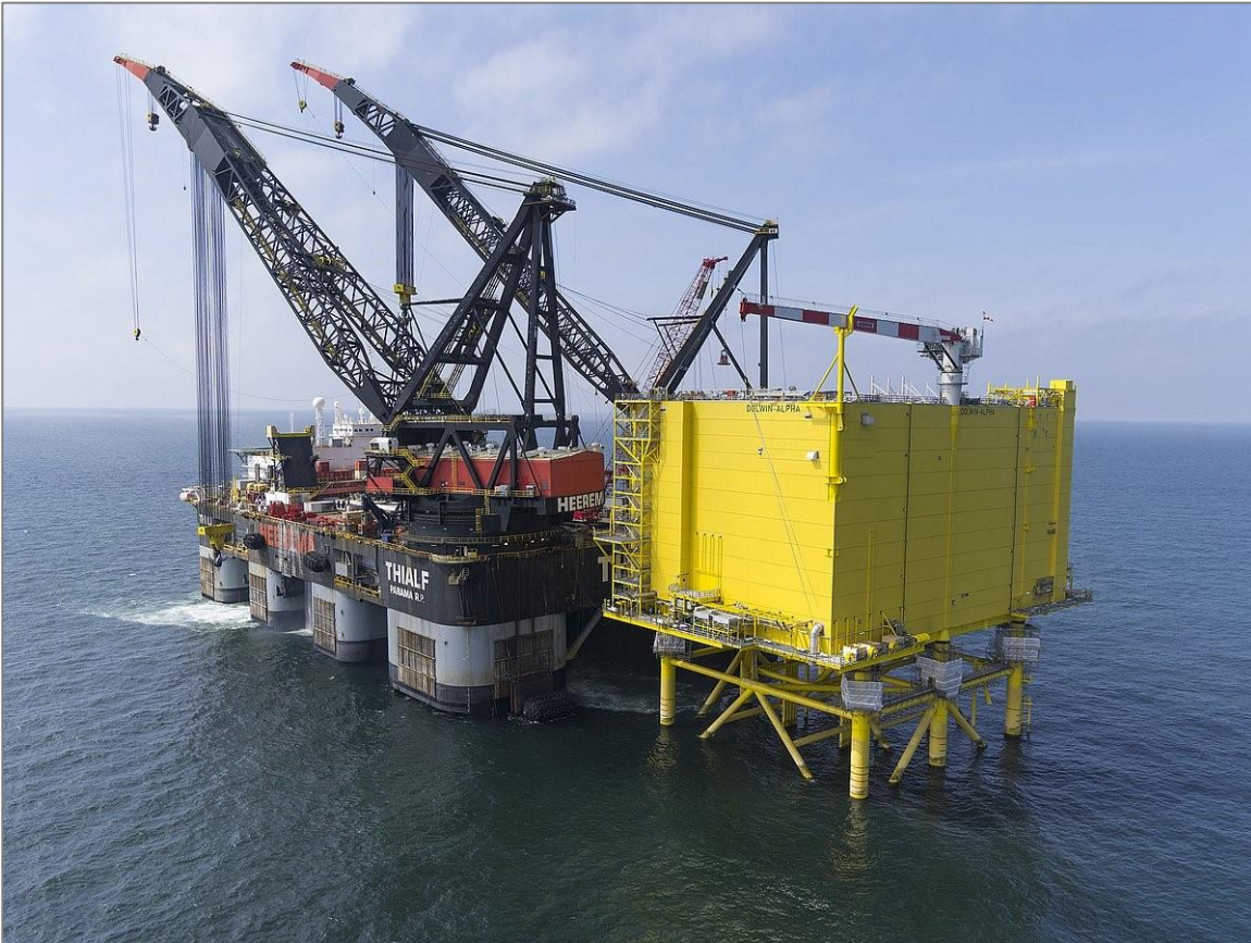
Bild 4-7. HVDC DolWin Alpha, ett exempel på en station med fackverksfundament. Kranfartygets lyftkapacitet är cirka 22 000 ton. Källa: www.overdick-offshore.com .
