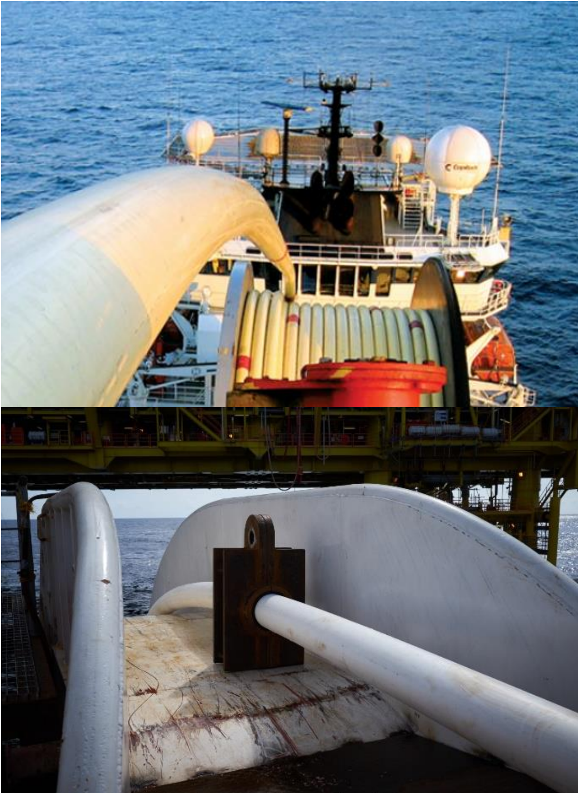
Bild 4-4. Förläggning av ett flexibelt vätgasrör. På den nedre bilden har man lagt vikter runt röret. Källa: SoluForce.
